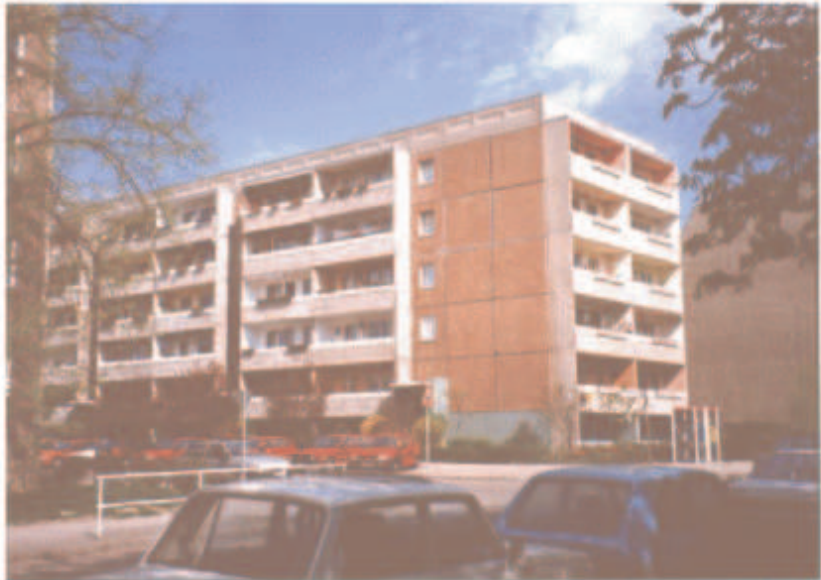
5geschossige Wohngebäude WBS 70, Standorte in Zwickau, Wohngebiet Eckersbach, und in Berlin-Hohenschönhausen
