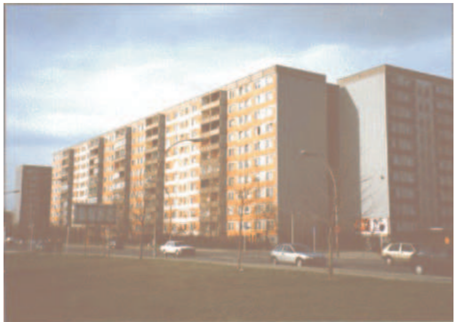
10geschossige Wohnblockbebauung WBS QP 71, Standort Berlin-Lichtenberg
