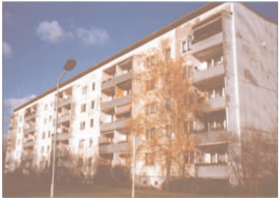
5geschossiger Wohnblock mit Flachdach (Innenentwässerung), Standort Potsdam, Wohngebiet Waldstadt
