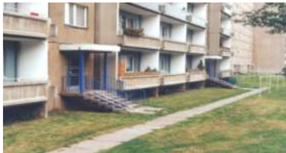
Ansicht Plattenbau WBS 70
