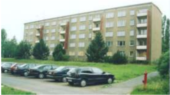
Ansicht Blockbau Kitzscher bei Leipzig
