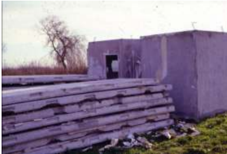
Lagerplatz der rückgebauten Platten auf dem Gelände Des Forschungsbüros in Espenhain
