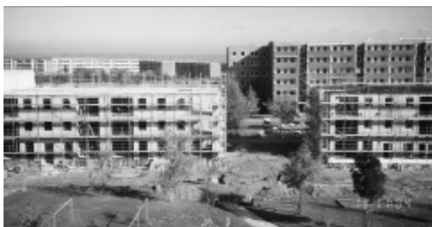
Abb. 2: Rück- und Umbau in der „Kräutersiedlung“ 2004/2005 [Foto: GRAS, Dresden]
