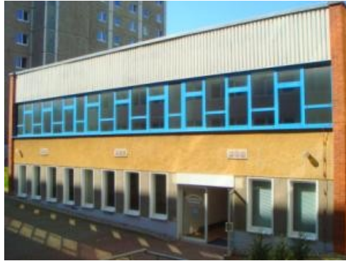
Der zweigeschoßige Flachbau, 2002 heiztechnisch an das Hochhaus angeschlossen.
