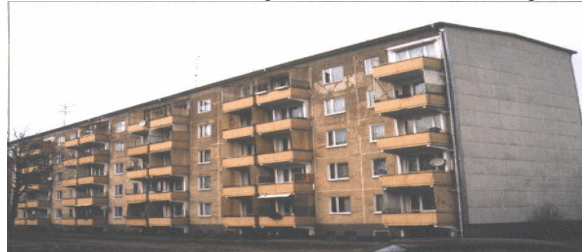
5geschossiger Wohnblock, Standort Rostock-Südost
